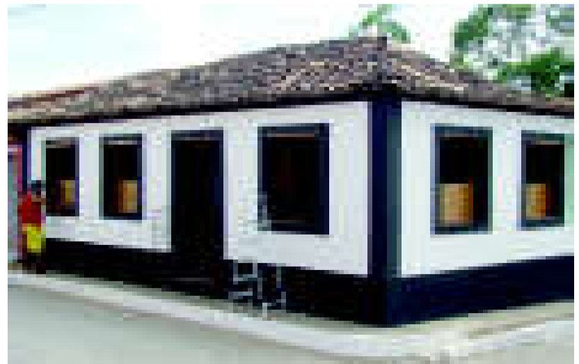
Exemplo para a comunidade - enquanto muitos destroem, pouquíssimos tentam preservar. No final da Rua Grande, a antiga e pequena casa de estilo colonial (onde morou D. Raquima Azevedo) recebendo nova pintura
