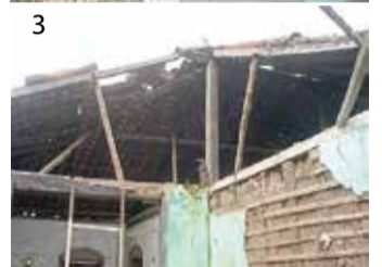
Foto 1: Fachada deteriorada do sobrado (no detalhe, parte do telhado que desabou); Foto 2: Vista interna da varanda do prédio, após o desabamento; Foto 3: Sem parte do telhado, paredes de adobe estão expostas às intempéries
