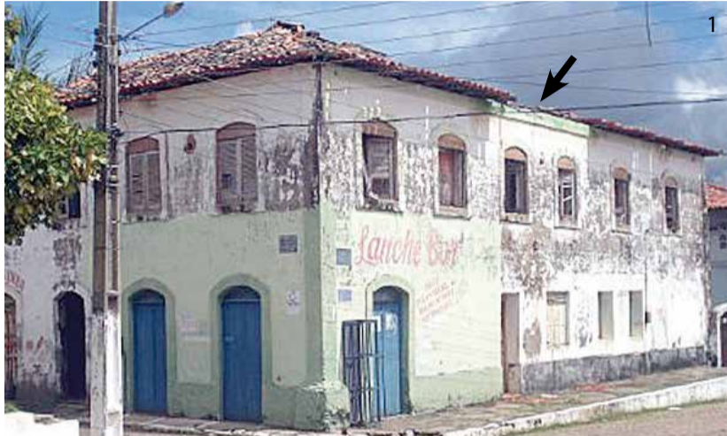
Foto 1: Fachada deteriorada do sobrado (no detalhe, parte do telhado que desabou); Foto 2: Vista interna da varanda do prédio, após o desabamento; Foto 3: Sem parte do telhado, paredes de adobe estão expostas às intempéries
