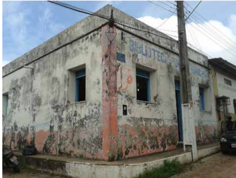
Com visível aspecto de abandono, o prédio que abriga a centenária biblioteca
