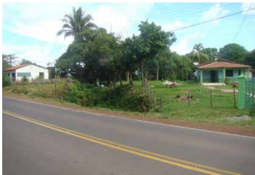
Trecho da rodovia MA 014, no Ibacazinho, que soterrou grande parte do fojo (ao fundo)
